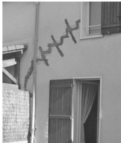
Réparation des dégâts produits par le phénomène de retrait-gonflement des argiles sur la façade d'une maison. Sources : BRGM ▶
