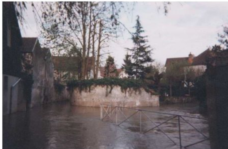
Crécly-la-Chapelle – inondations avril 1999
